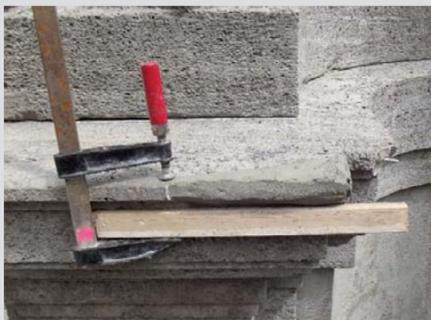
Auftrag des Remmers Grundiermörtels zum Aufbau einer Fehlstelle.
