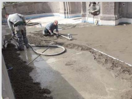
Aufbringen einer Ausgleichsschicht aus Beton mit Gefälle.
