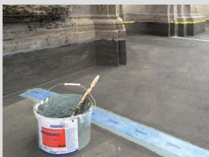
Einarbeitung von Dichtungsbändern an den Rändern und Dehnungsfugen.
