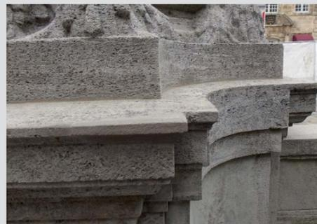
Die Formergänzung mit Remmers Restauriermörtel nach Überarbeitung und Anpassung an die Steinoberflächen.
