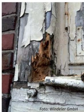
Nach Freilegung der morschen Eckverbindungen zeigten sich die Schäden an den Holzfenstern.
