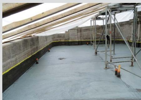
Nach Grundierung mit Kiesol erfolgte der Auftrag von MB 2K als Kratzspachtelung zum Verfüllen von Poren und Rauhtiefen.
