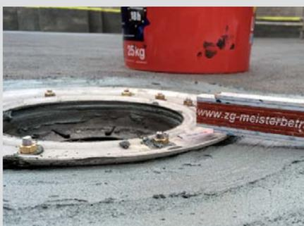
Einarbeitung eines Wasserablaufes mit MB 2K (Multi-Baudicht 2K).
